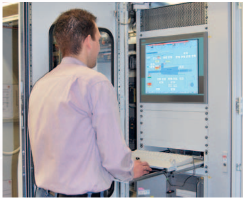
RST-Softwareingenieur bei der Endabnahme einer Visualisierungs-Software für eine Gasturbine
