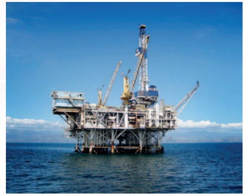
Kompressoren und Gasturbinen werden auf Plattformen z.B. zur Rückverdichtung von Erdölbegleitgas eingesetzt
